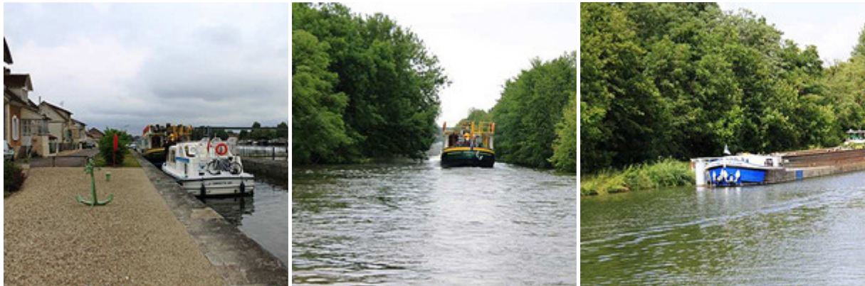
Schleuse von Auxerre, Ausweichkanal von Gurgy und Schweizer Kanalschiff
